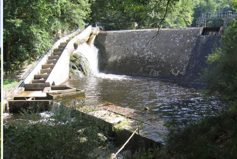
Le barrage de Bussy à Eymoutiers est muni d'une passe à poissons, ouvrage hydraulique qui assure la migration des poissons en permettant notamment le franchissement piscicole.
