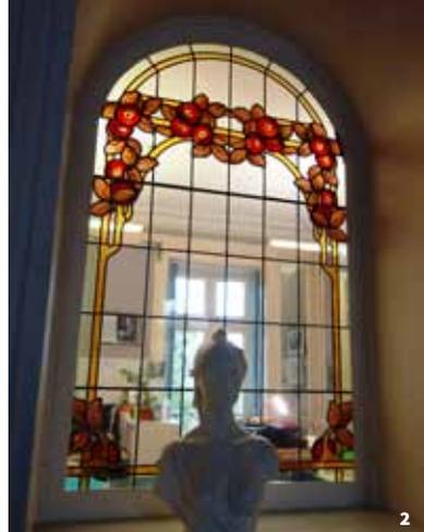
Le mastic comble les espaces entre plomb et verre pour garantir étanchéité et rigidité. Il doit sécher durant deux mois.
